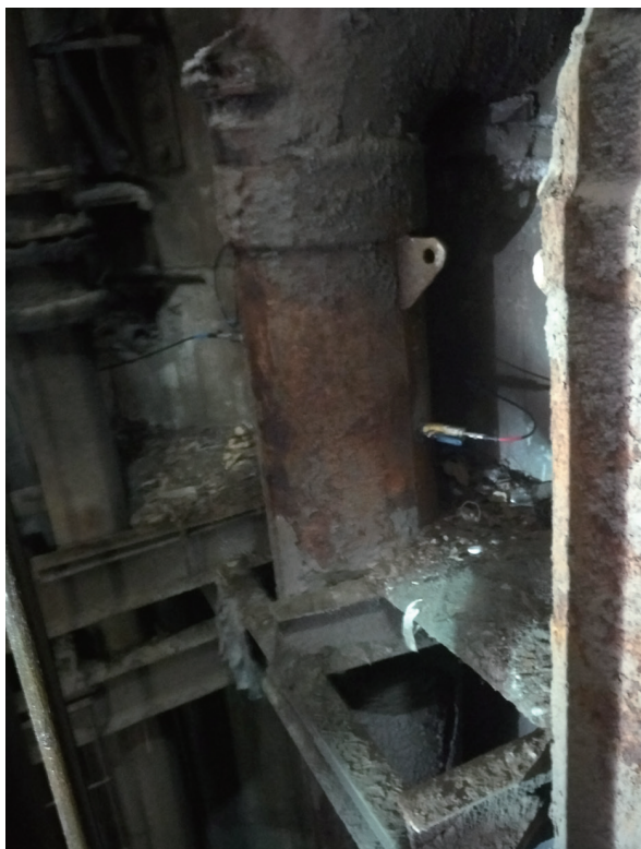
井下大管道安装案例
