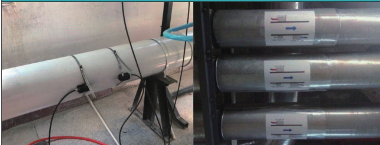
外夹式传感器，中央空调冷冻水测量，主管道DN300
